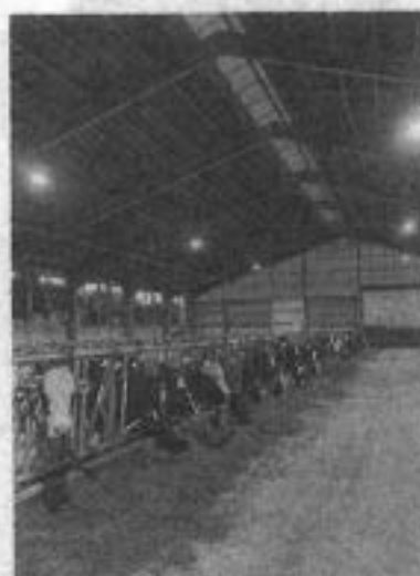
Das Lochblech im hinteren Teil des Boxenlaufstalls lässt nicht nur Luft rein, sondern hält auch Regen ab.
